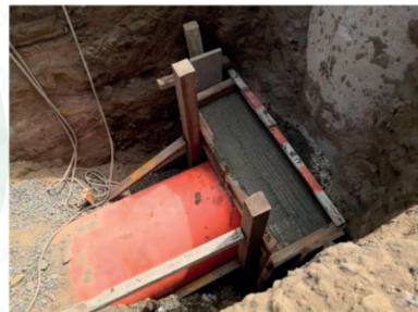
Figura 5: HORMIGÓN COMPLETAMENTE CURADO
