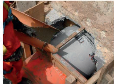
Figura 4: HORMIGÓN EN PROCESO DE CURA
